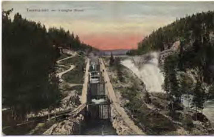
Figur 95 Historisk bilde frå bygginga av Vrangfoss sluser. Hentet fra Fylkesbiblioteket i Telemark sin prosjektside om Skiensvassdraget.
